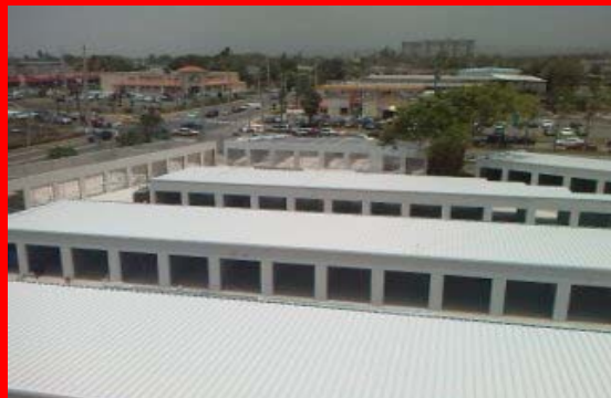
Techo sobre Mini Warehouse de Carolina
