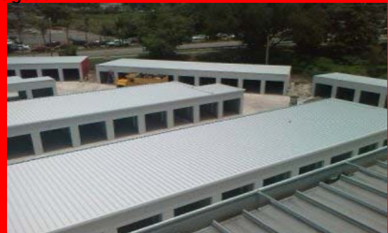
Techo sobre Mini Warehouse de Carolina
